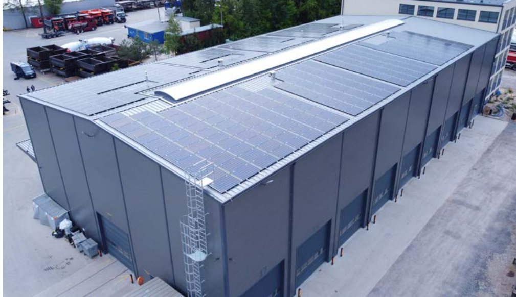
Montaż instalacji fotowoltaicznej o mocy 150 kW na dachu nowej hali montażowej. Installation of a 150 kW photovoltaic system on the roof of the new assembly hall.
